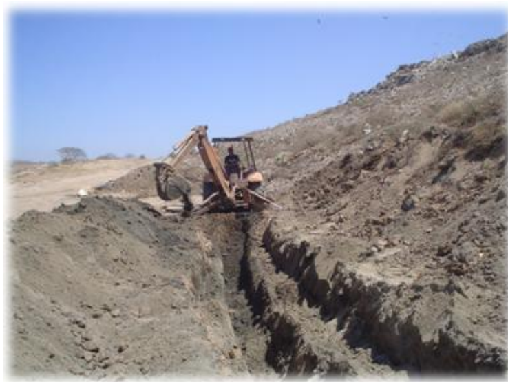
Figura 47 Apertura de Canales para conducción de Lixiviados. 90
