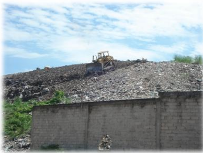
Figura 42 Conformación y Estabilización de Taludes 87
