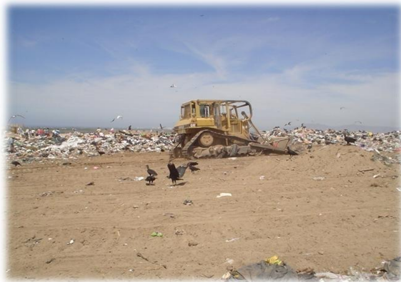
Figura 43 Cobertura de Residuos con Material Terrígeno 88
