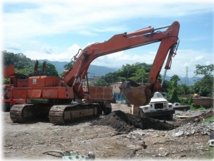
Figura 45 Construcción de Fosa para la Captación de Lixiviados. 89
