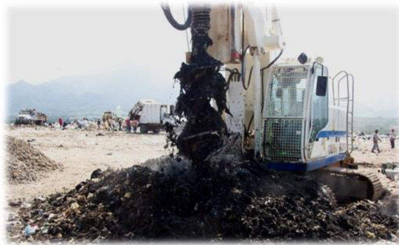
Figura 48 Perforaciones para Venteo de Biogás 91
