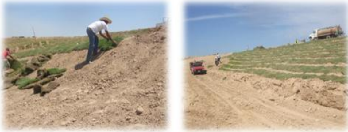
Figura 44 Colocación de Pasto en el SDF " El Magisterio"
